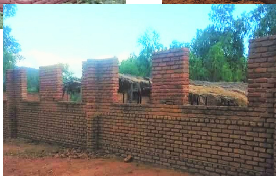
Seurakuntamme Mzuzussa tarvitsee rakennusmateriaaleja, kuten sementtiä.
